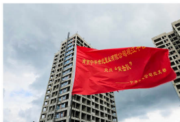
党员突击队队旗在施工现场高高飘扬
